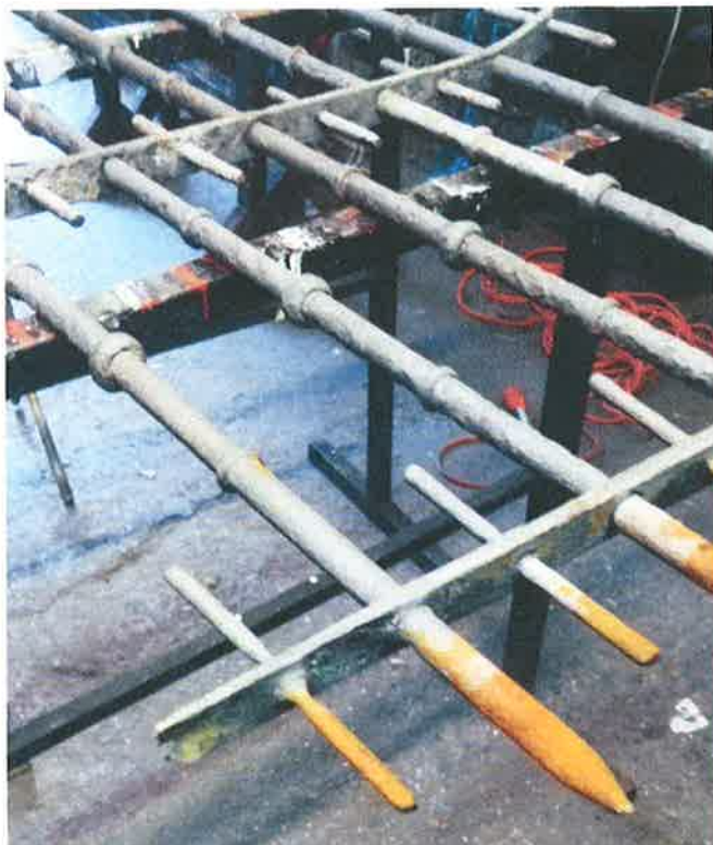
Stav brány a plotu po odstranění nátěrů pískováním
