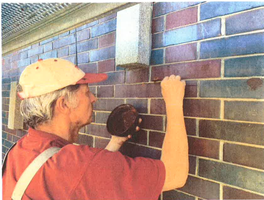
Vzorek tmelení lícového zdiva
