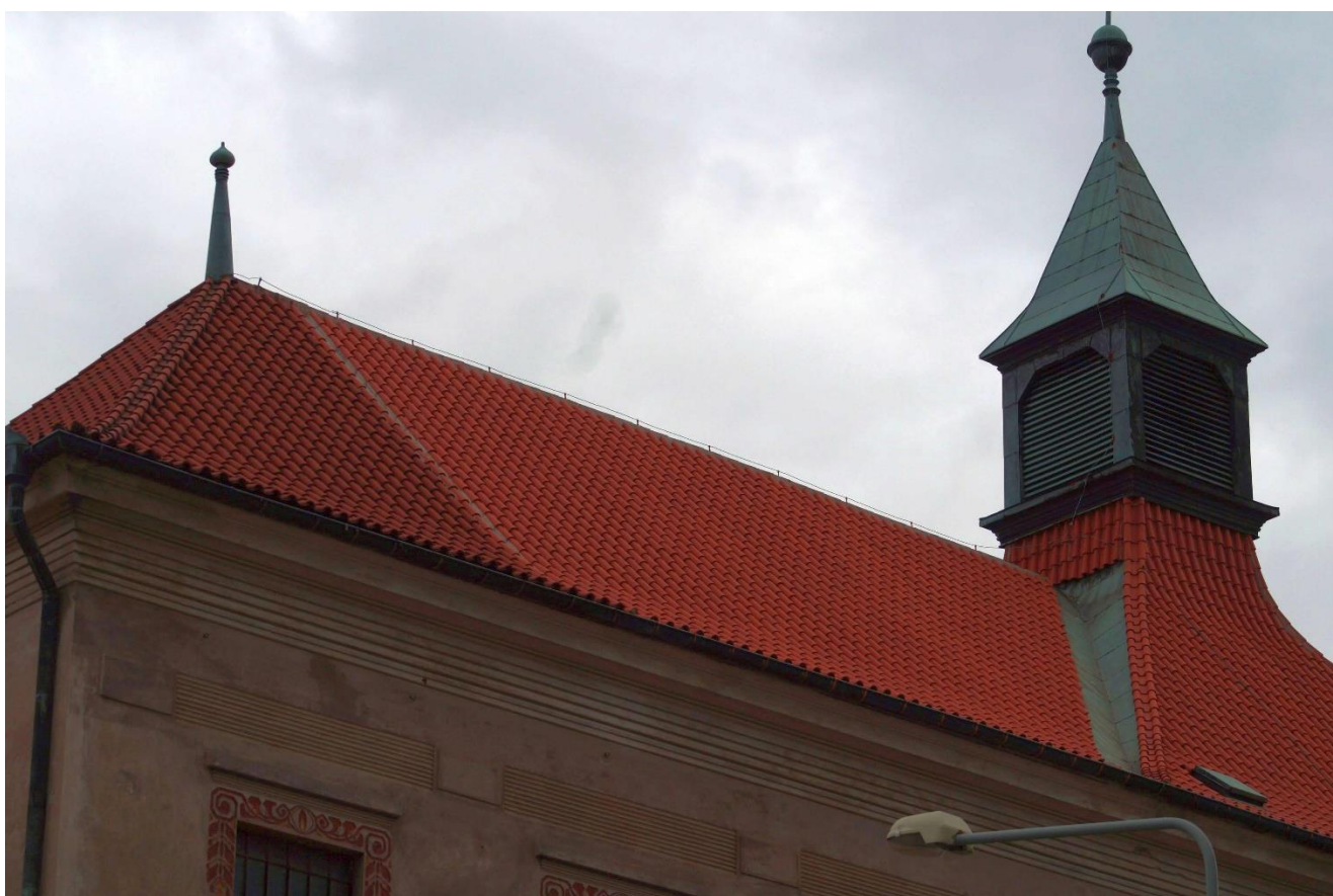
Kostel sv. Anny v Praze na Žižkově – výměna prejzové krytiny nad hlavní lodí po valbu - 2021
