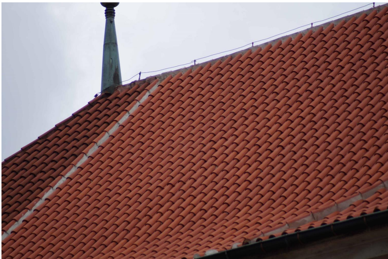
Kostel sv. Anny v Praze na Žižkově – výměna prejzové krytiny nad hlavní lodí po valbu - 2021
