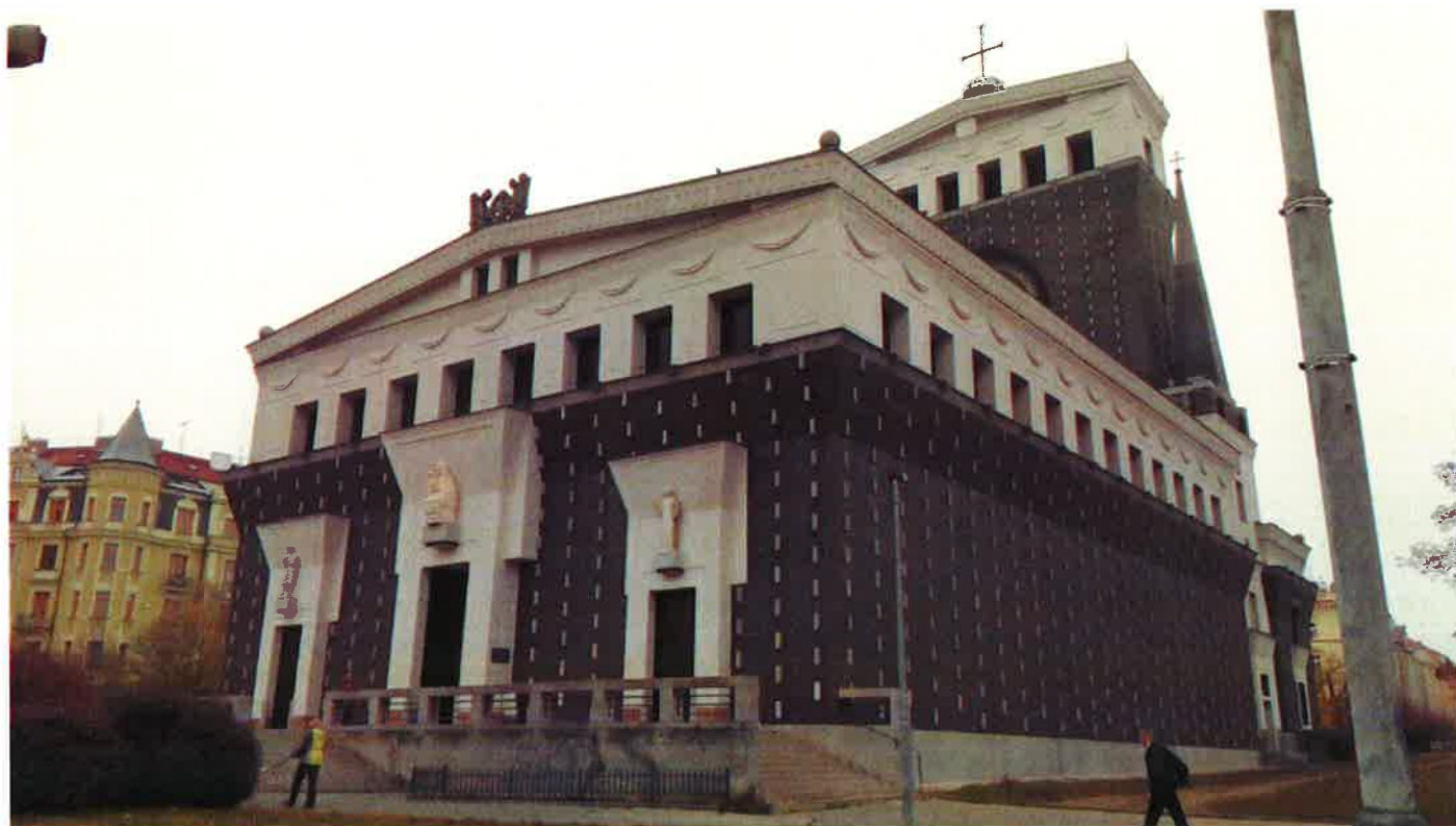
Stav po dokončení
