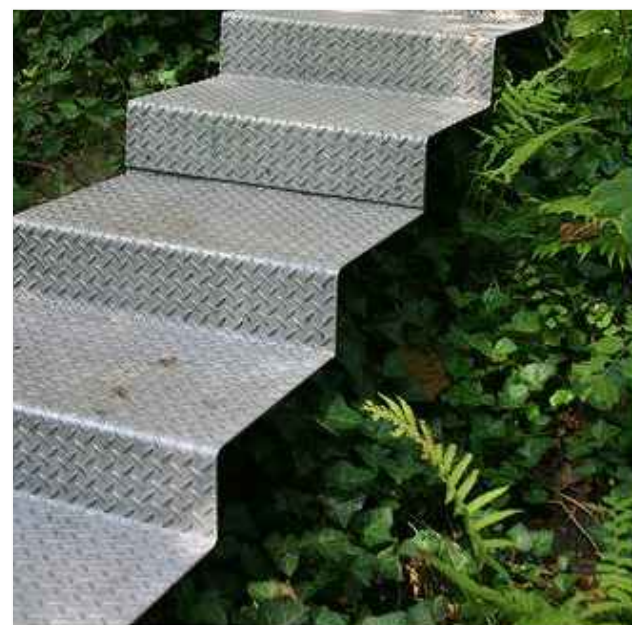
schodiště slzičkový plech
